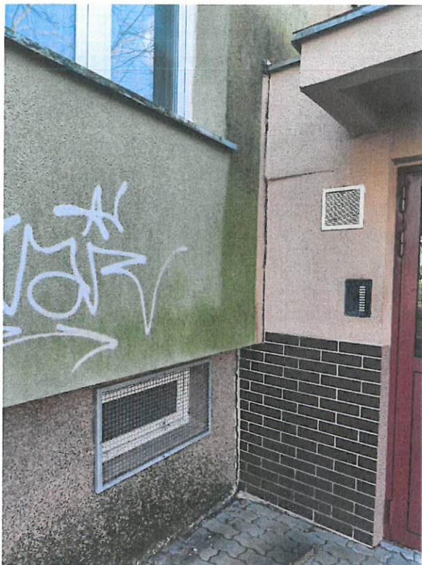
FOT. 4 i 5 Zarysowania w gankach wejściowych kl. 78, 80, 82
